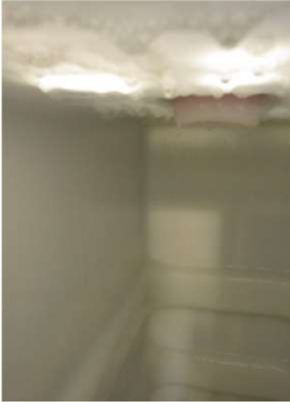
Abb. 37c: Schaummittelreste an der Tankdecke und Spülvorgang den Tankwänden müssen mit möglichst heißem Wasser (50–60 °C) gelöst werden.
