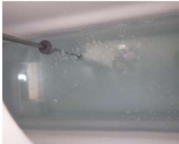
Abb. 37c: Schaummittelreste an der Tankdecke und Spülvorgang den Tankwänden müssen mit möglichst heißem Wasser (50–60 °C) gelöst werden.
