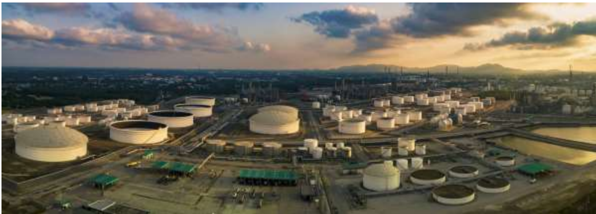
Abb. 30: Bei Industrieanlagen, wie hier einer Raffinerie, sind in der Regel Anlagen zum Löschwasserrückhalt vorgeschrieben.
